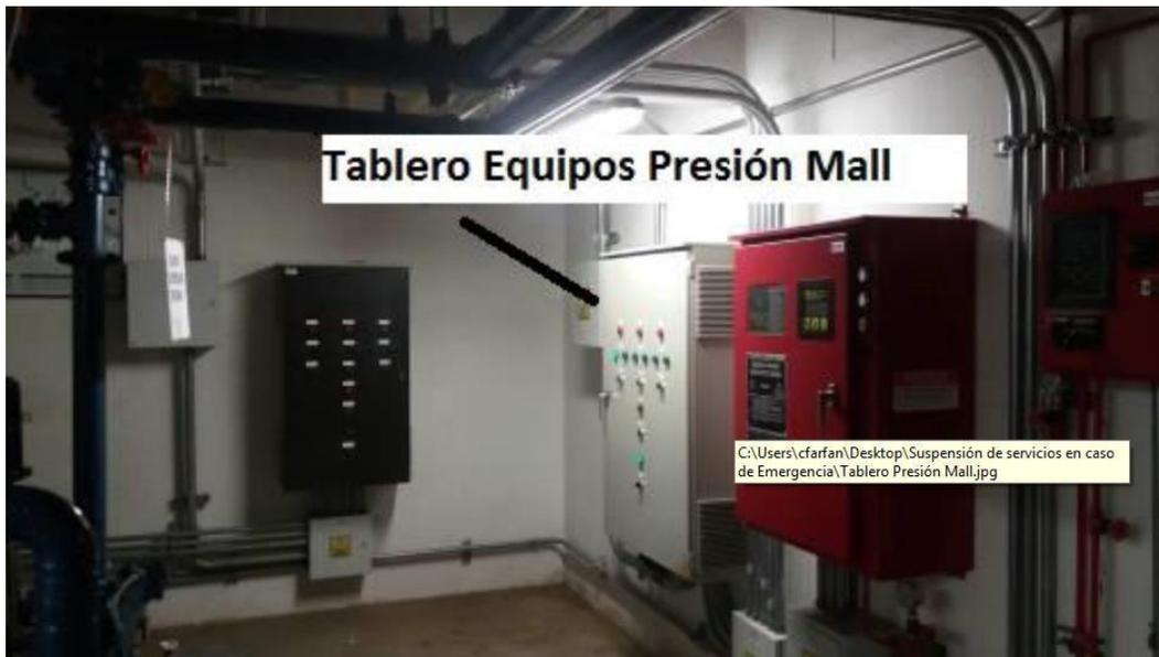
**Fig. 6. Tablero Equipos Presión Mall**
