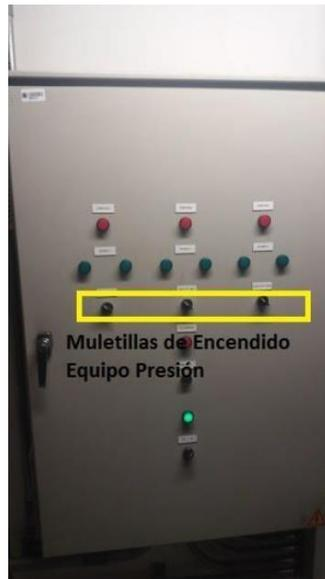
**Fig. 7. Tablero de Control Equipo de Presión Mall**
