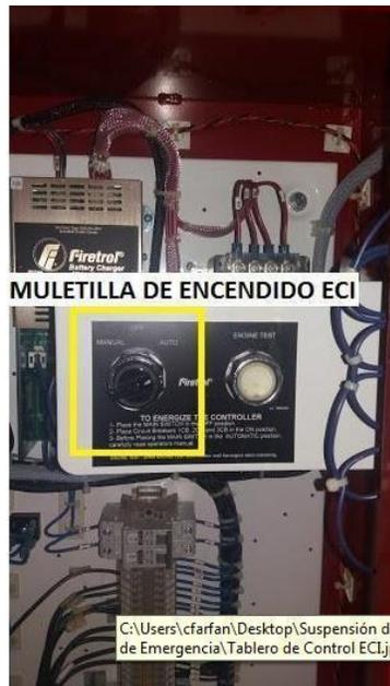
Fig. 12. Muletillas de Encendido ECI
