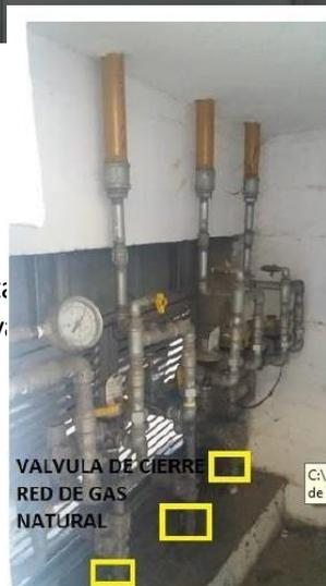
Se realiza la apertura de la puerta de la estación de gas para inhabilitar las tuberías de los locales de comidas del Mall, las válvulas de cierre se encuentran en la parte inferior de la tubería como se puede observar en la **Figura 2**
